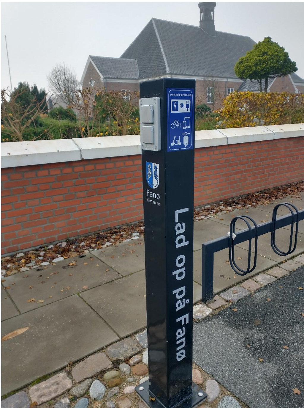
Kombineret ladefacilitet til cykler, elscootere og mobile devices på Fanø.
